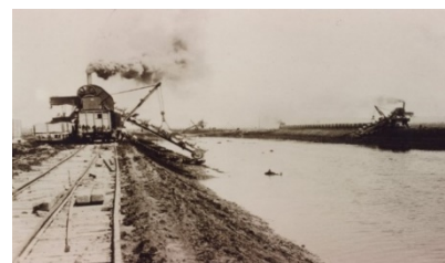
掘削機エクスキャベーター作業状況
