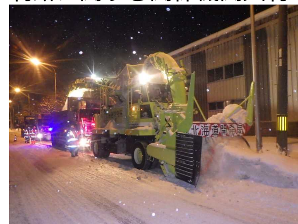
▲令和4年度の除排雪状況 （国道274号 白石区）
