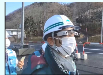
ウェアラブルカメラによる現場実況
