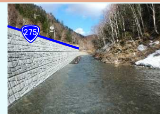
国道275号 対策事例
