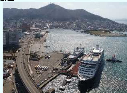
函館港 若松地区 クルーズ船岸壁完成 （令和5年3月）
