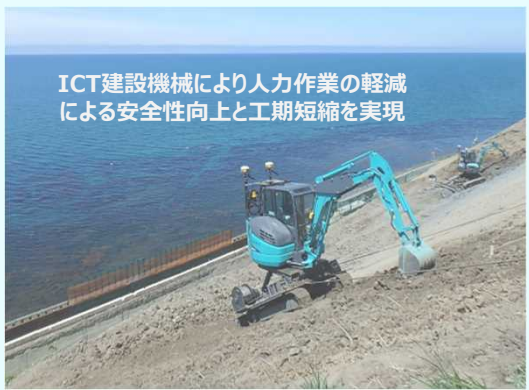
< I C T建設機械による施工状況 >
