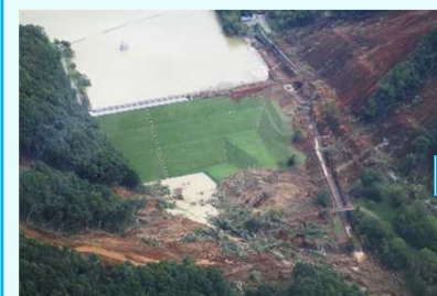
厚真ダムの被災
