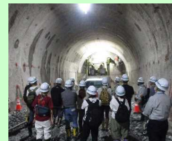
新稲穂トンネル共和工区工事現場の説明風景(令和4年8月8日)
