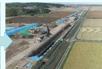
導水路復旧工事 (R3.9)
