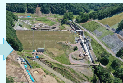
洪水吐復旧工事 (R4.8)
