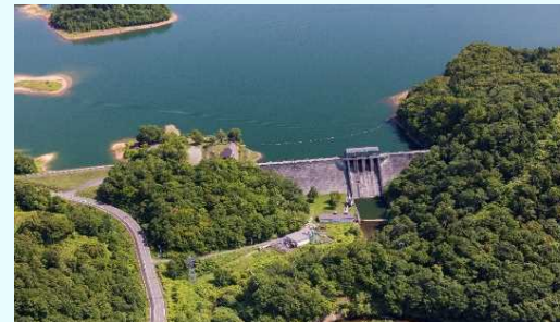
雨竜第1ダム （容量振替）
