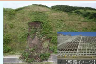
国道232号 苫前町力屋地区
