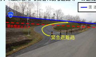
国道276号 京極町更進地区(対策事例)
