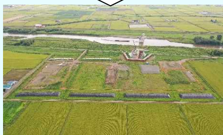
改修中の頭首工 (R4.8)
