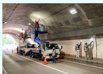
トンネルの点検状況
