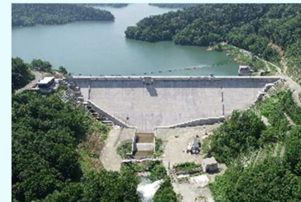
新桂沢ダム（堤体かさ上げ）
