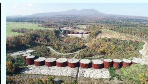
樽前山覚生川1号砂防堰堤 (苫小牧市)
