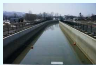
老朽化した農業用用水路の改修
