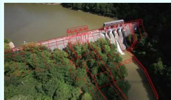
雨竜第2ダム (幌加内町)
