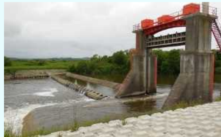
防災対策が必要な頭首工
