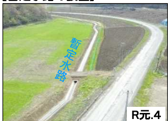
【暫定水路の設置】
