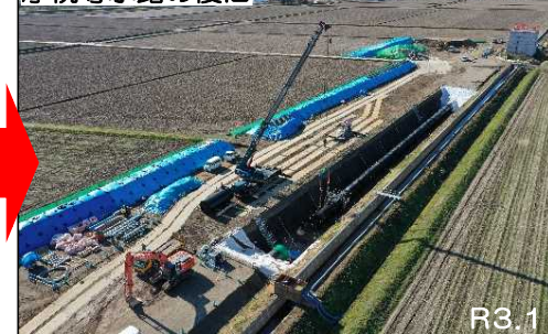
厚幌導水路の復旧
