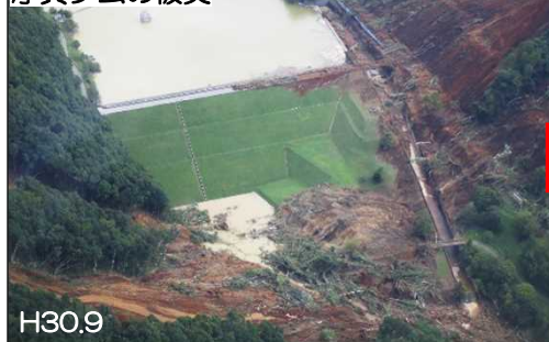
厚真ダムの被災
