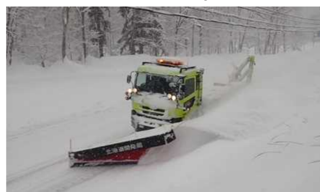
▲集中除雪作業の状況 (国道38号 狩勝峠) R4.12.23
