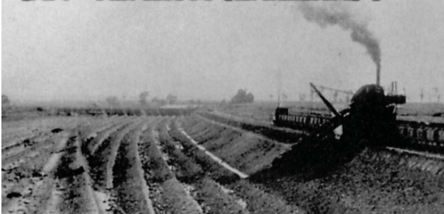
掘削機エクスキャベーターによる統内新水路の作業状況 (出典：十勝川治水史 (北海道開発局))
