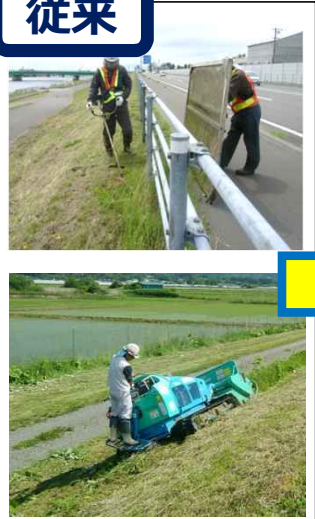
作業員が除草機等で実施
