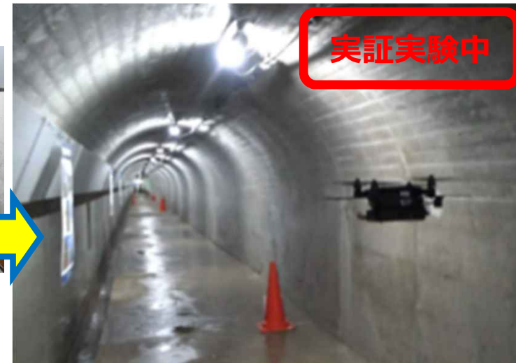
ドローンによるダム内監査廊点検の状況 (実証実験)
