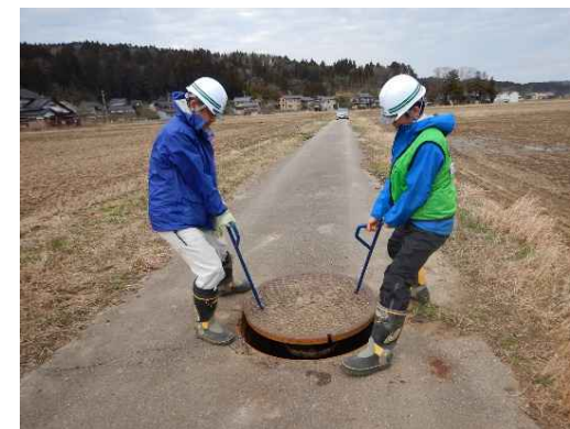
↑弁室の開閉作業
