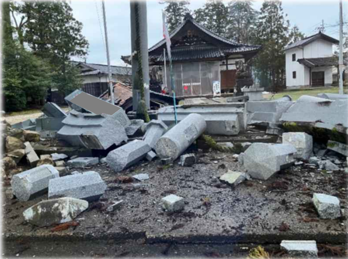
↑ 神社石柱の倒壊
