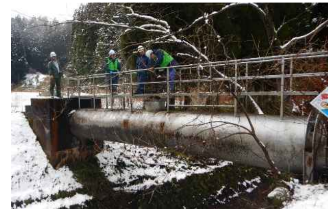
↑水管橋上の確認
