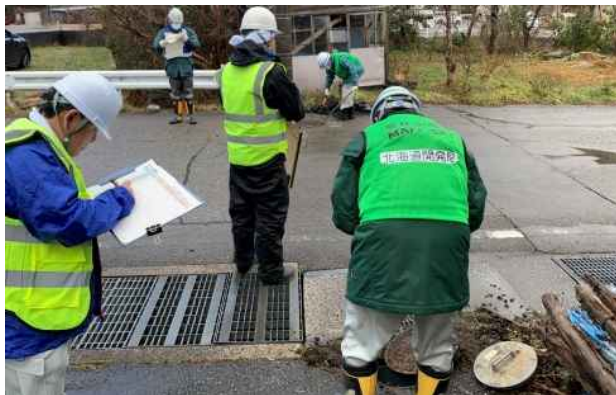
←管路内被災調査②
