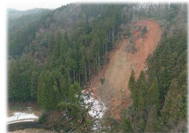
↑ドローンで撮影した被災箇所の様子
