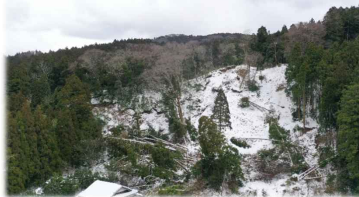
ドローンで撮影した被災箇所の様子
