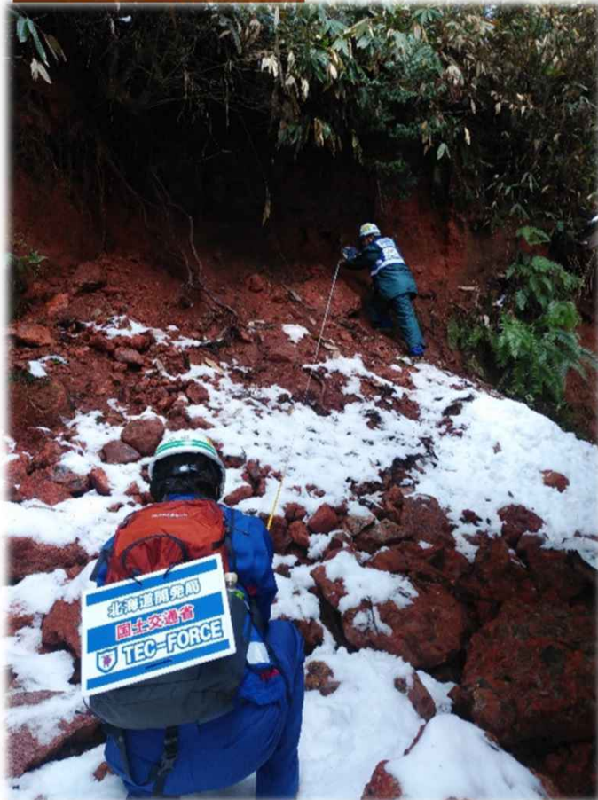
被災箇所調査の様子
