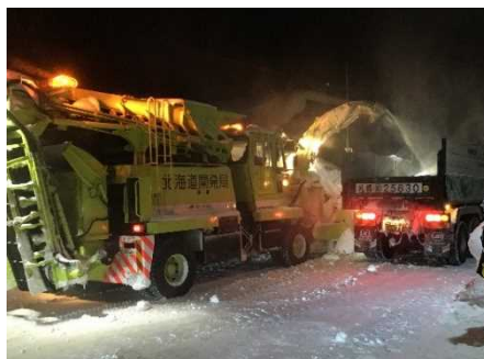
写真：貸与機械による排雪状況（滝川市）
