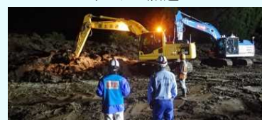
24時間体制での土砂撤去作業
