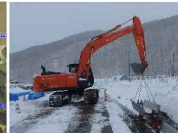
暫定的な用水路の敷設工事
