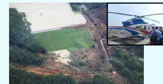
防災ヘリからの被災状況調査
