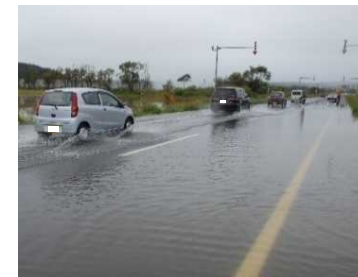
道路冠水に関する緊急対策
