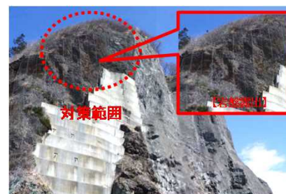
道路法面・盛土に関する緊急対策
