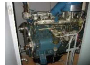
非常用電源設備等の更新
