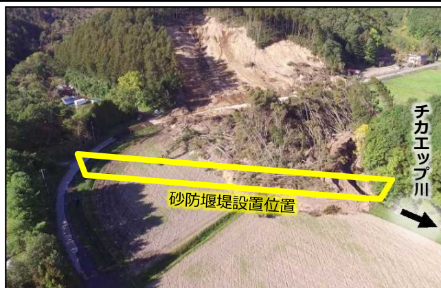
チケツペ川支川の緊急的な対策状況
