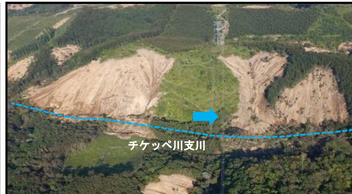
チケッペ川支川の山腹崩壊状況
