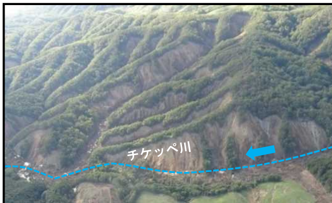
チケッペ川の山腹崩壊状況
