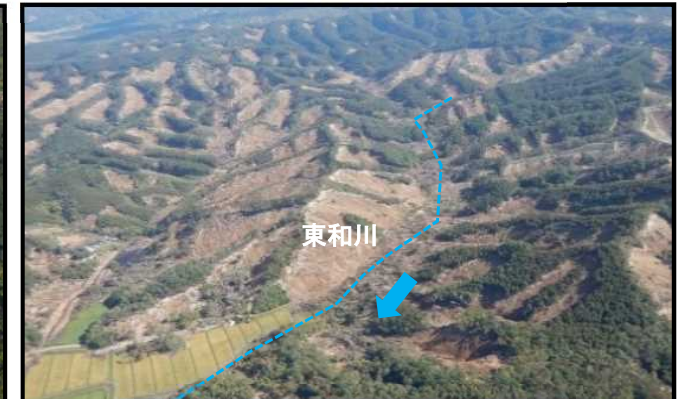
東和川の山腹崩壊状況
