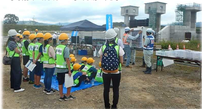
工事概要の説明・工事現場の見学
