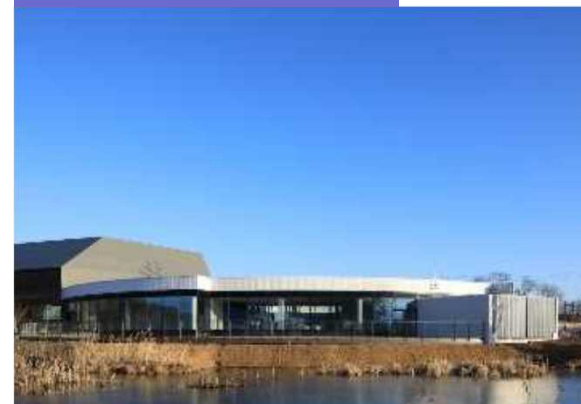
エントランス棟
