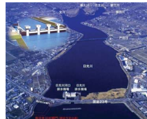
水閘門改築事業の全景
