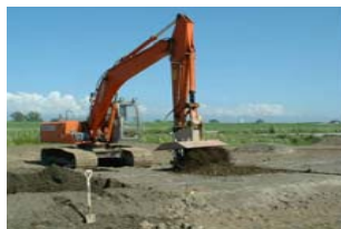
混ざりやすく時間短縮 新工法：ロータリースタビライザー
