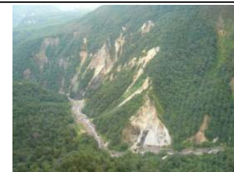
山地の荒廃状況(層雲峡地区)
