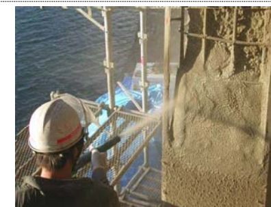
断面修復による長寿命化
