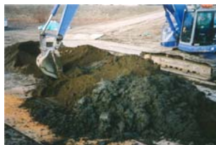
混ざりにくく時間がかかる 従来：バックホウ混合
