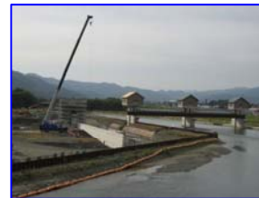
頭首工の整備 【空知川頭首工】
