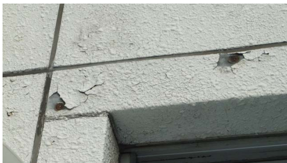
帯広地方合同庁舎の外壁改修等の事業を実施
