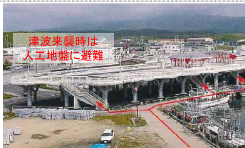
津波来襲時は人工地盤に避難 (青苗漁港)
