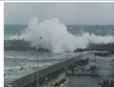
防波堤からの越波状況 (江良漁港)
