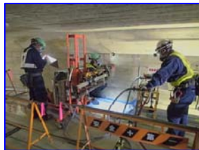
空港施設の耐震補強 【函館空港】
