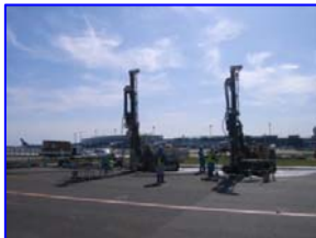
空港の液状化対策 【新千歳空港】
