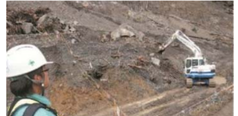
遠隔操作により安全施工
