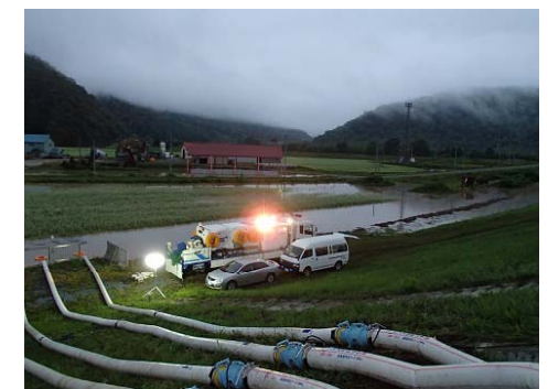
音威子府村天塩川での内水排除
