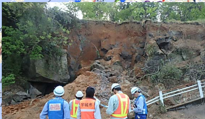
宇城市豊野(とよの)地区の市道法面における岩塊崩落箇所調査状況(4月20日)
