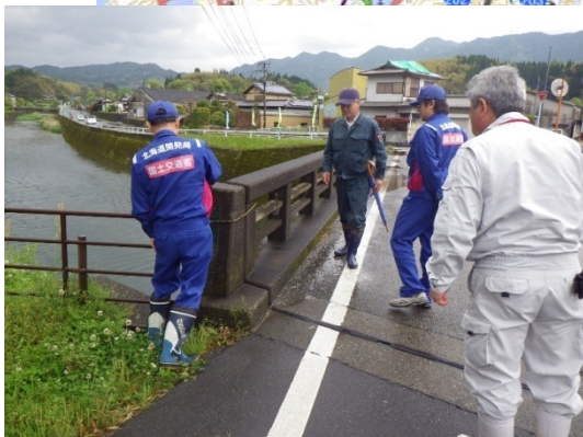
宇城市で道路被災状況調査をする道路班(4月21日)
