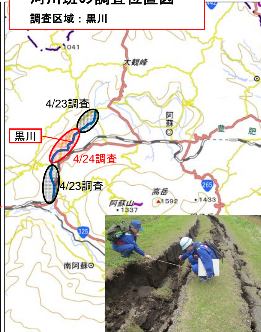
堤防の破損を確認する河川班
