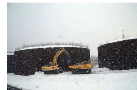
吹雪の中での無人化施工によるブロック積工
