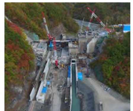
平取ダム堤体建設工事 全景
