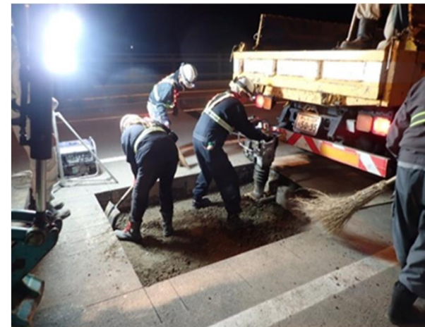
補修状況：国道12号（北海道札幌市）
