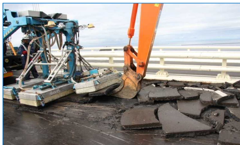
I H工法による舗装剥離、撤去
