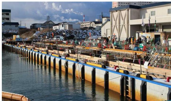
地中はり鉄筋組立の施工状況
