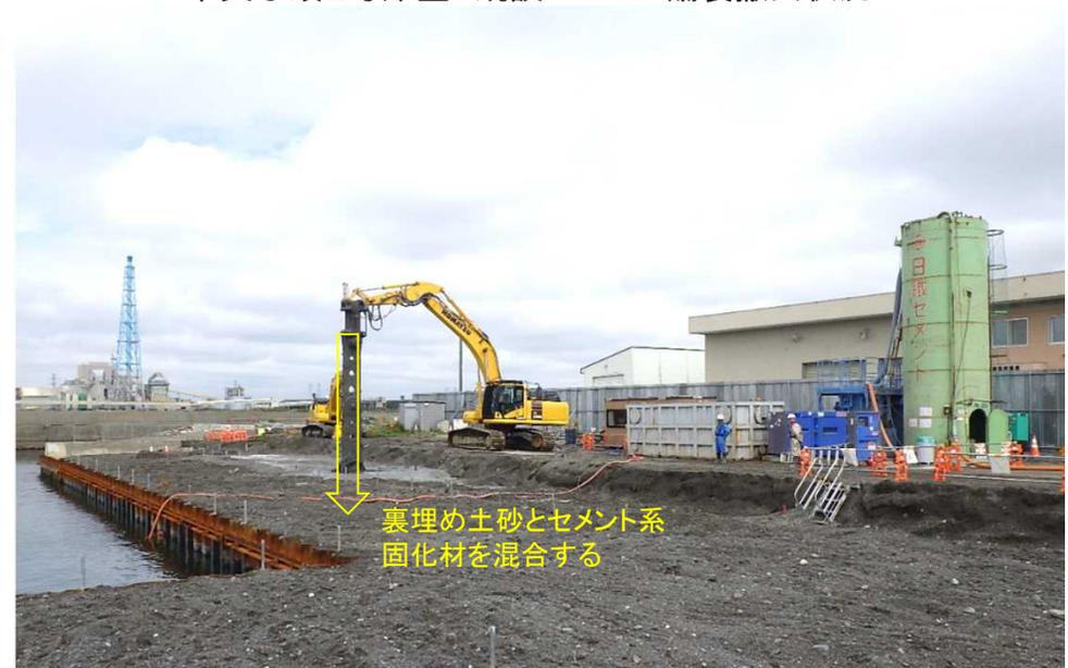
船だまり-3M物揚場 地盤改良工(中層混合処理)実施状況
