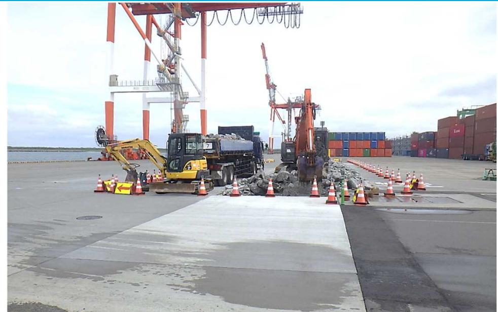
中央ふ頭2号岸壁 既設エプロン舗装撤去状況
