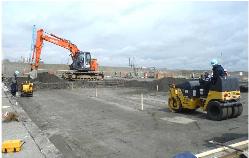
船だまり船揚場 復旧状況(路盤工)
