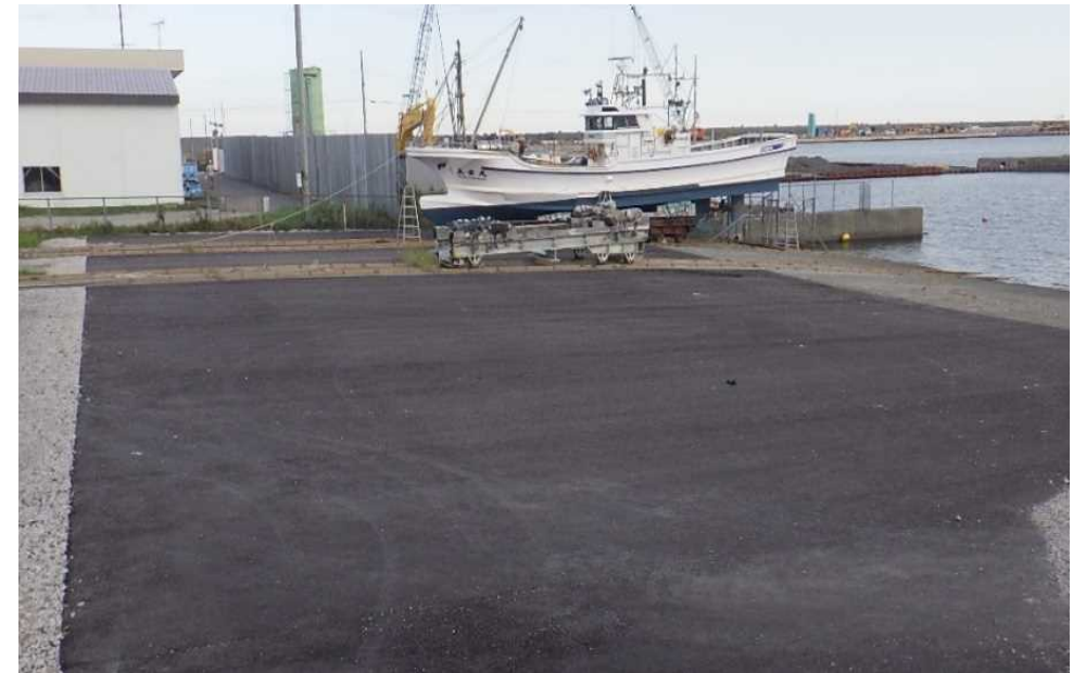
船だまり船揚場 完成後の利用状況
