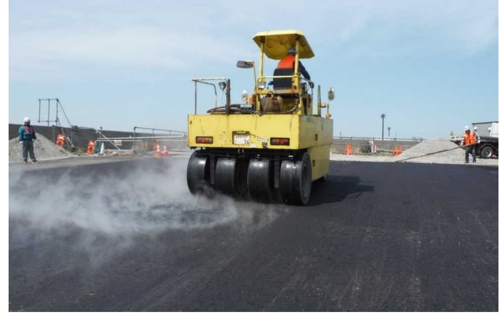
船だまり船揚場 復旧状況(アスファルト舗装)
