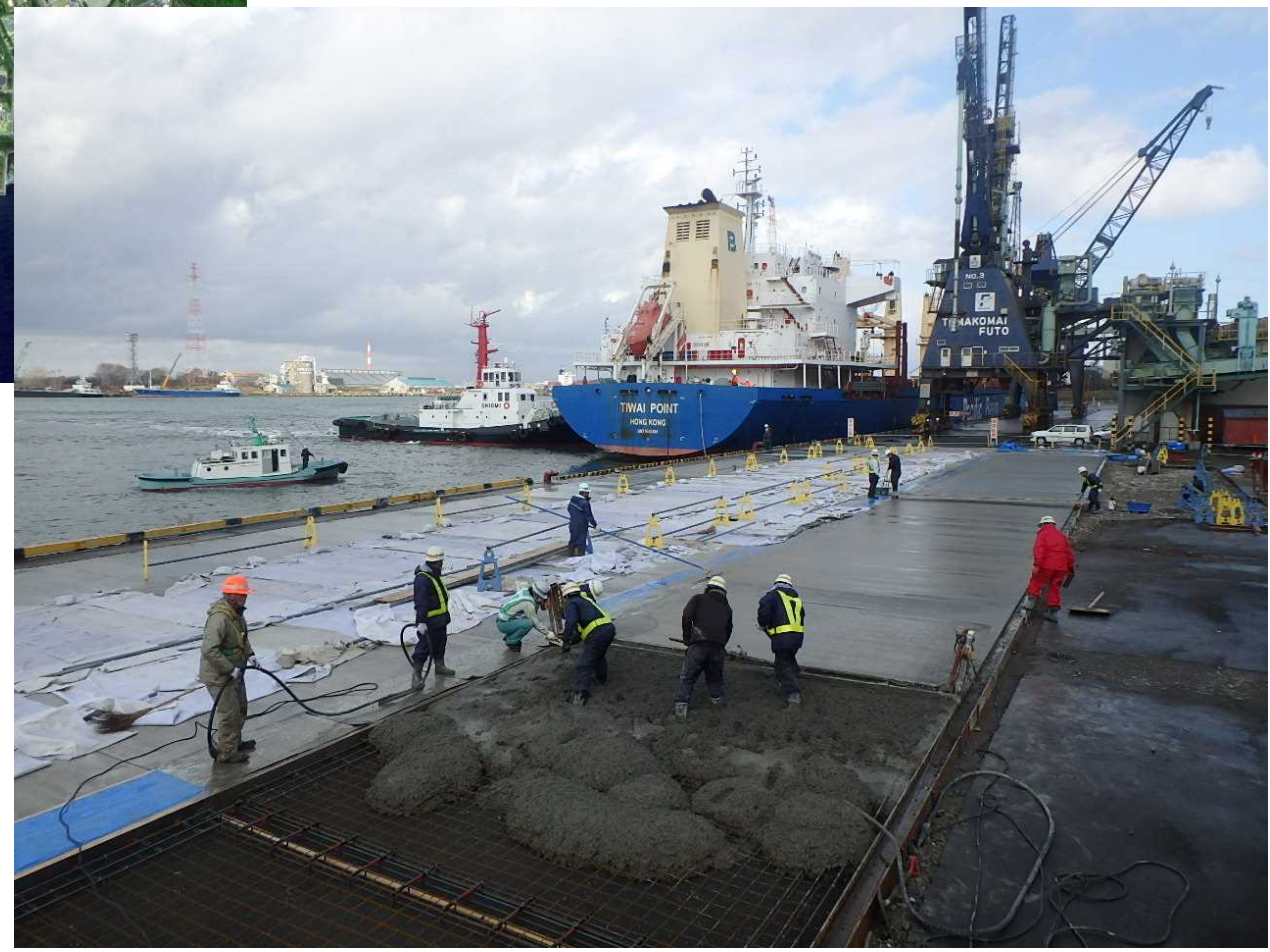
中央南埠頭1・2号岸壁 コンクリート舗装施工状況
