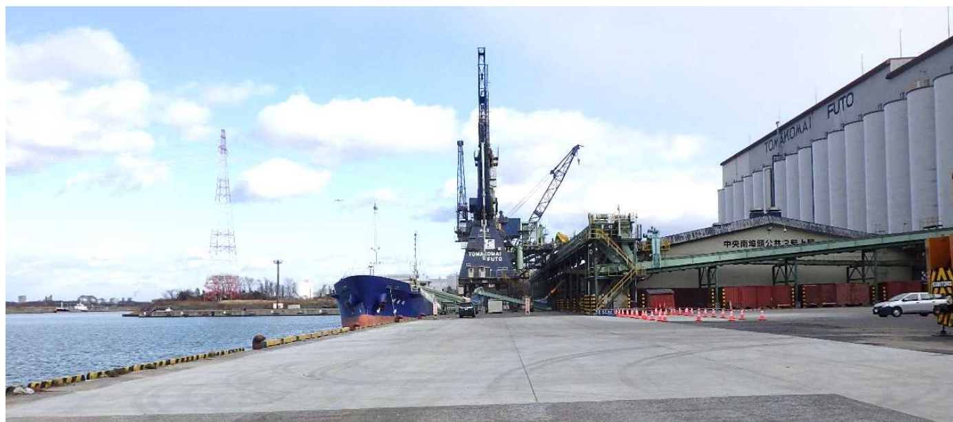
中央南埠頭1・2号岸壁 コンクリート舗装完成状況
