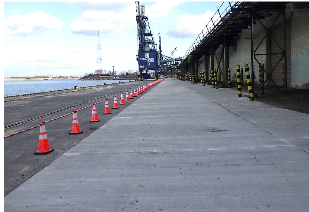
中央南埠頭1号岸壁 コンクリート舗装完成状況
