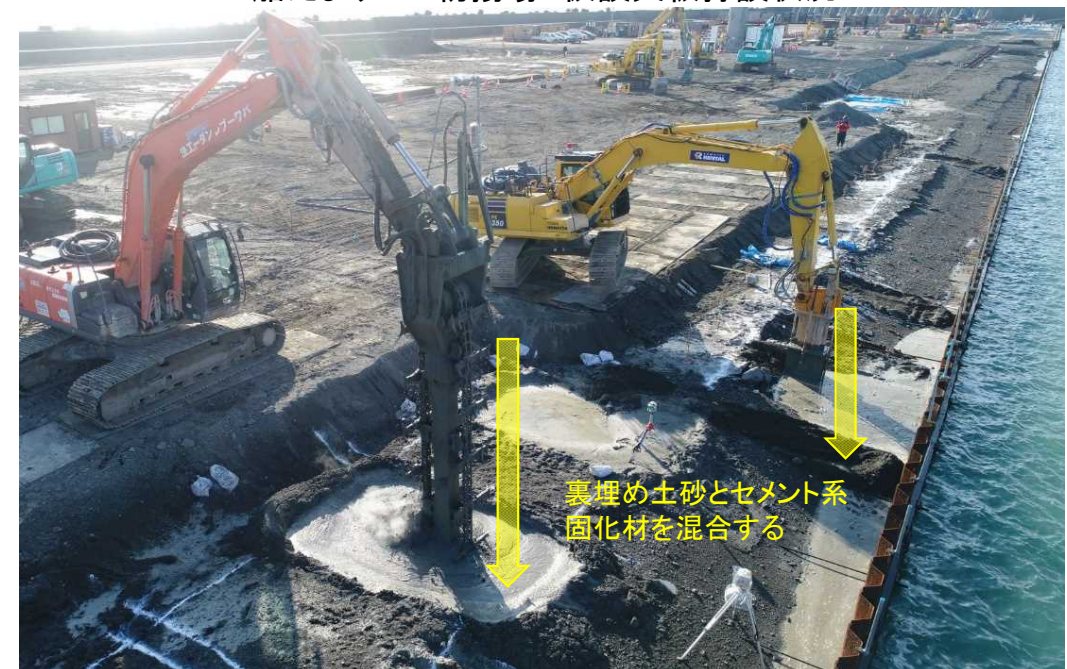
船だまり-4M物揚場 地盤改良工(中層混合処理)実施状況
