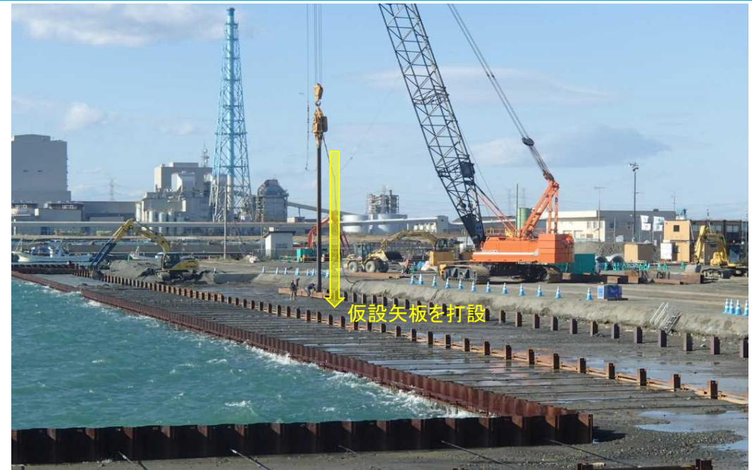
船だまり-4M物揚場 仮設矢板打設状況
