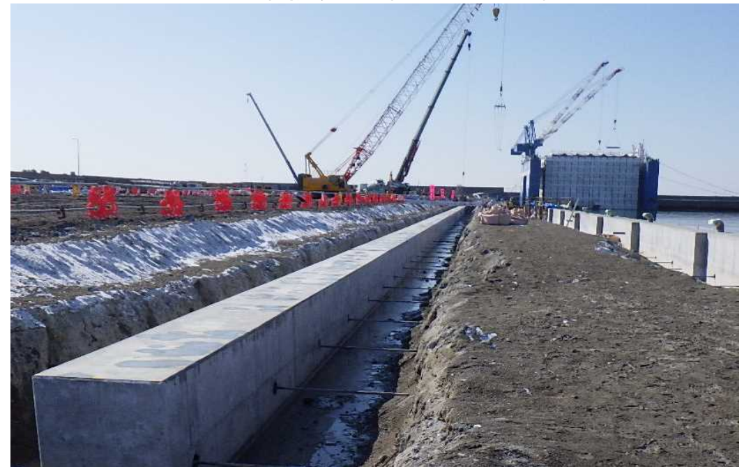
船だまり-4M物揚場 控えコンクリート完成状況
