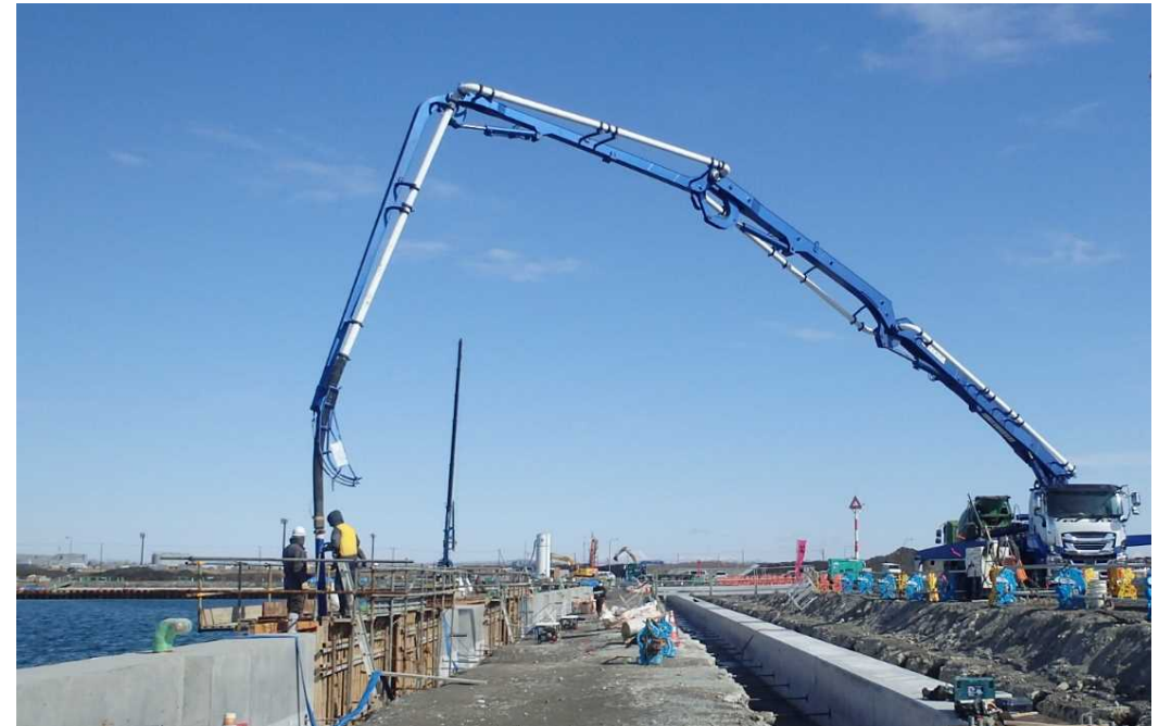
船だまり-4M物揚場 上部コンクリート打設状況
