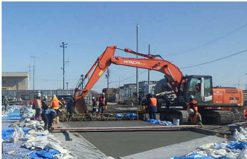
船だまり-3M物揚場 舗装コンクリート施工状況
