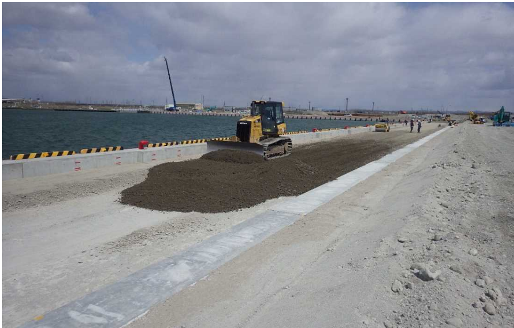
船だまり-4M物揚場 舗装工復旧状況
