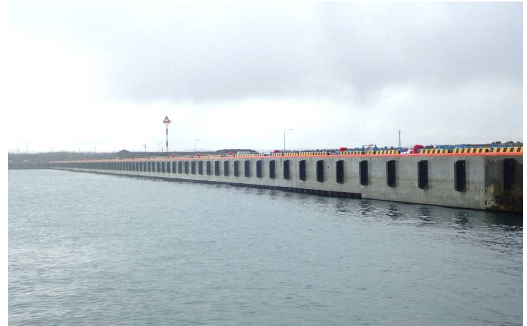
船だまり-4M物揚場 上部工完成状況
