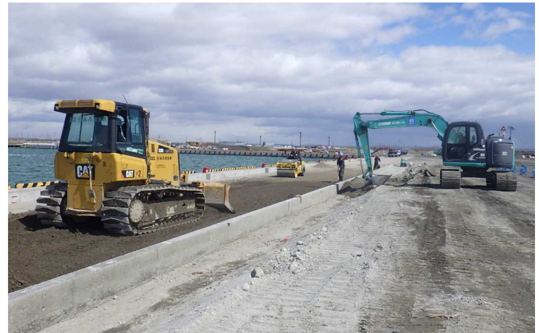
船だまり-4M物揚場 舗装工復旧状況
