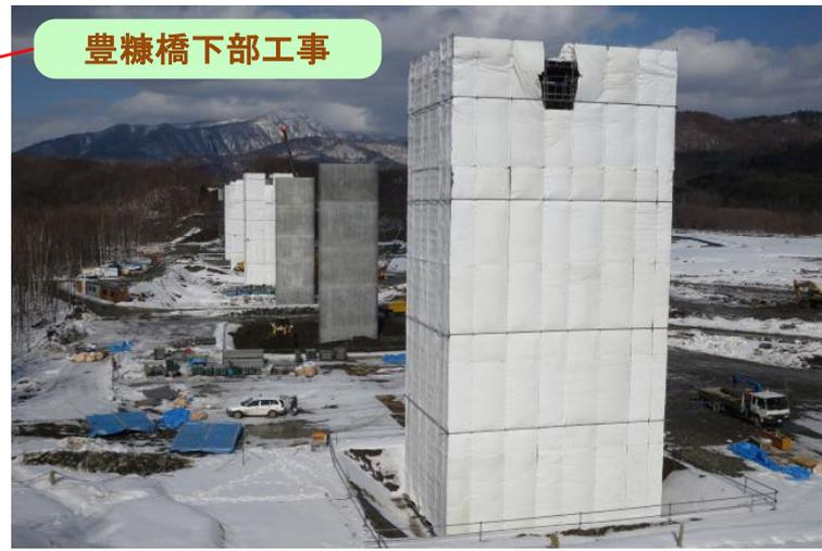
橋梁下部工事では、橋梁橋脚柱形式にML工法(新技術)を採用することにより、型枠・コンクリート・鉄筋数量の減少を図り、工期短縮及びコスト縮減に努めています。
