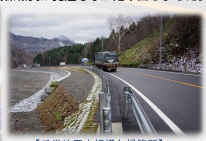
【千栄地区大規模欠損箇所】復旧後を通行する車両
