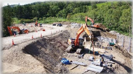
復旧工事の様子
