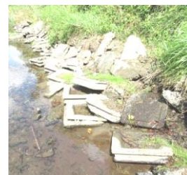
被災後の用水路(H30.9)
