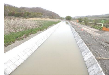
復旧後の用水路(R2.5)
