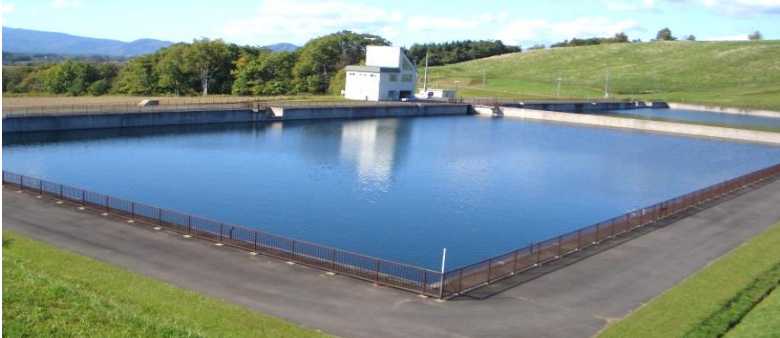
地域の水源施設である大原調整池
