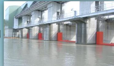
下流から見た左岸クレストゲートです。幅11m。高さ2.5m。重さ約22t。鋼鉄製。
