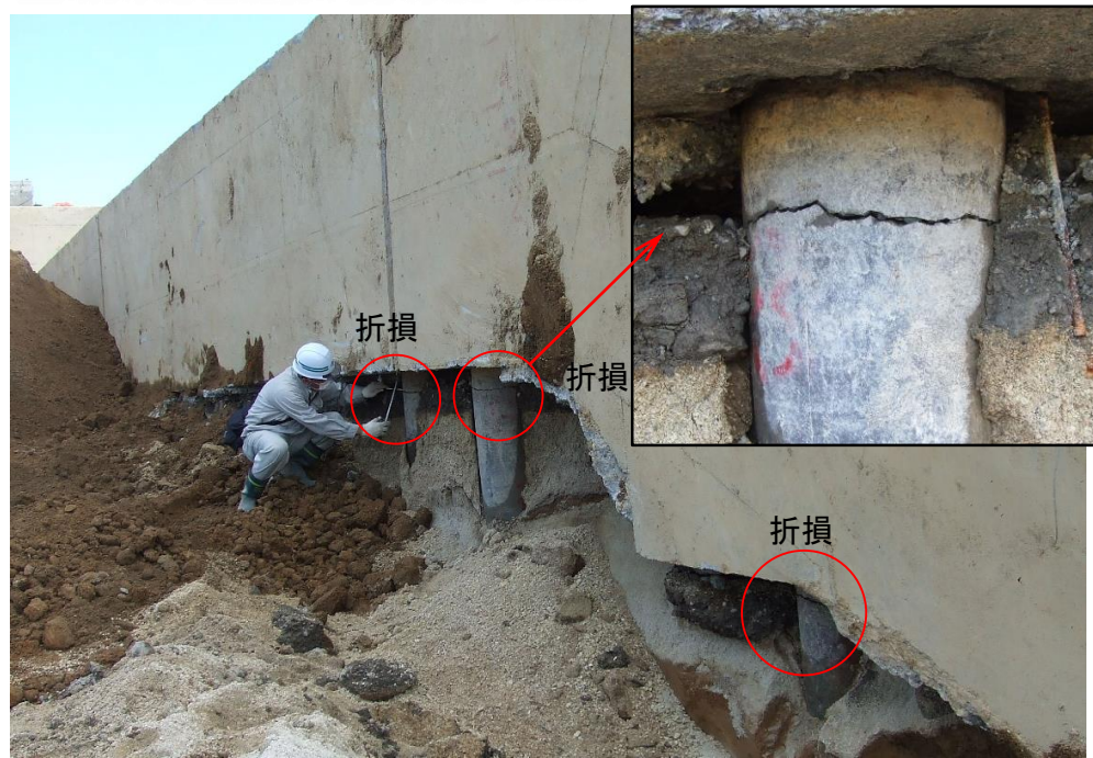
豊川分水路 基礎杭の被災状況(R3.6)
