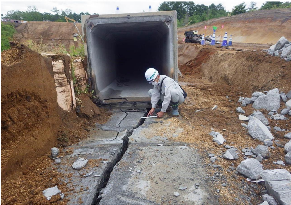
厚幌導水路(ボックスカルバート)の被災状況(R3.6)
