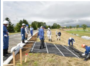
シート張り工実習
