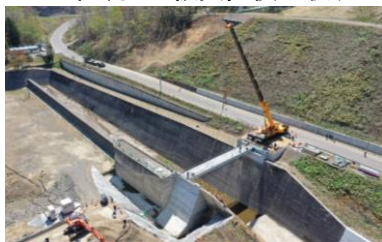
管理橋PC桁 設置状況
