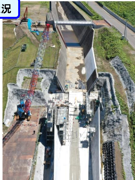
洪水吐復旧状況
