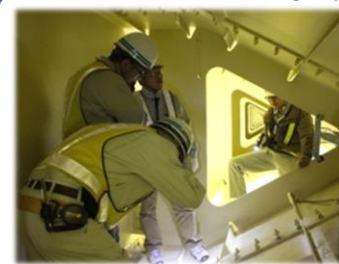
目視による橋桁内の点検
