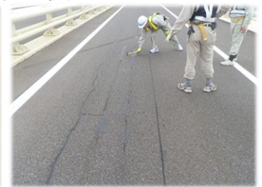
打音による舗装の浮きの確認
