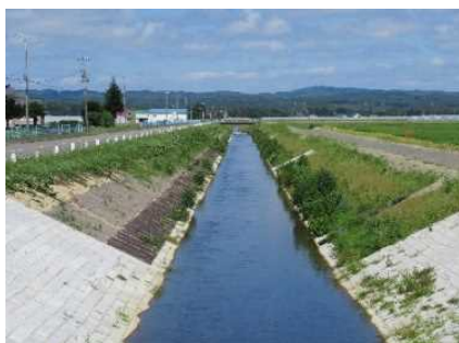
排水施設の整備による 農業生産の向上
