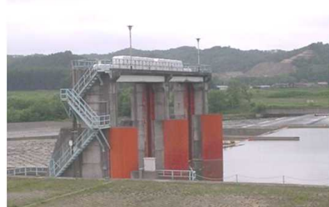
川東頭首工（昭和45年完成）
