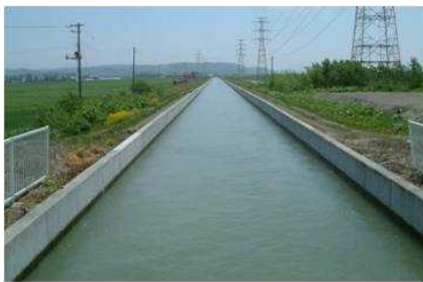
劣化が進行した施設の改修による 用水の安定供給
