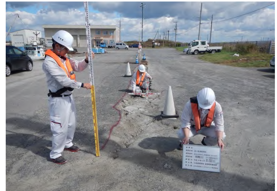
船だまり荷さばき地 起伏、地割れ、沈下
