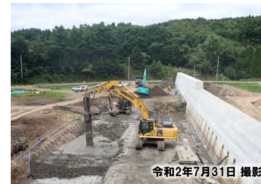
チカエツ川砂防堰堤 施工状況 (地盤改良)
