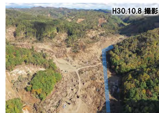
日高幌内川 緊急対策前
