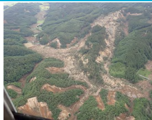
日高幌内山腹崩壊状況
