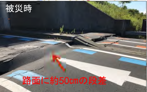
鷗川IC合流部の路面段差
