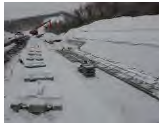
冬期間の工事状況
