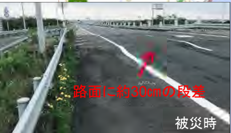
鷗川IC合流部の路面段差
