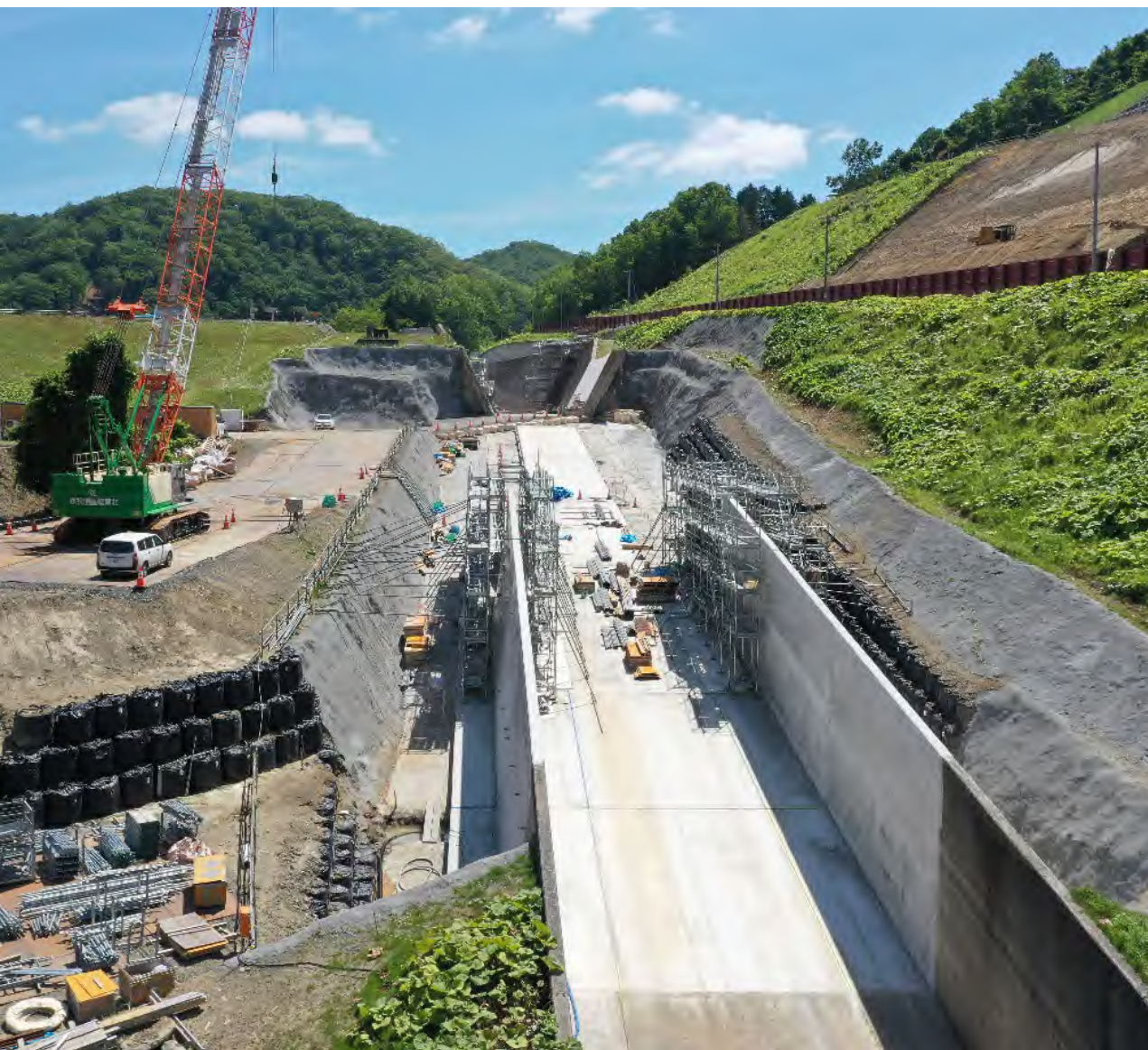
R3.7.16 洪水吐の復旧状況
