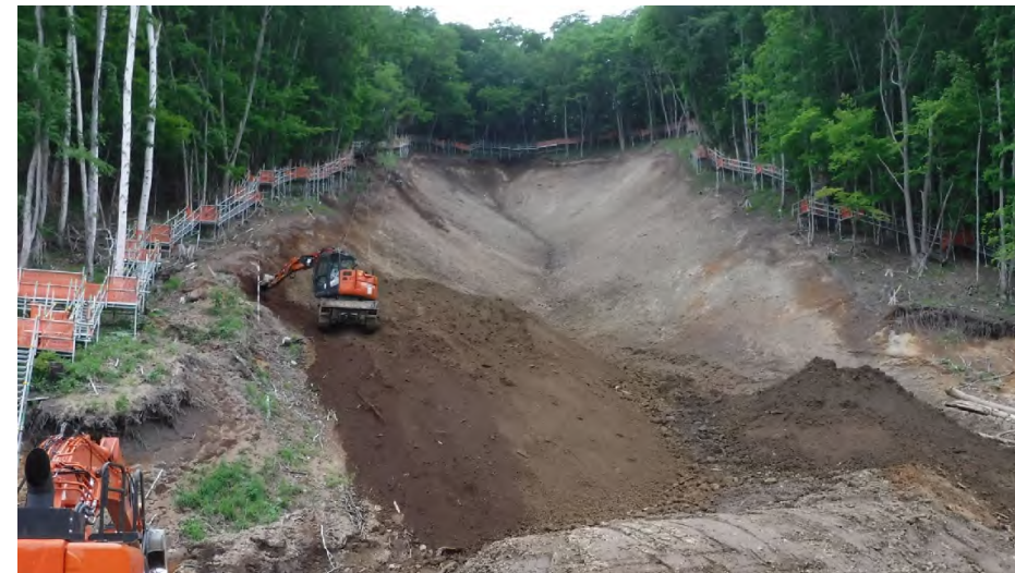
R3.6.17 崩落土砂の除去
