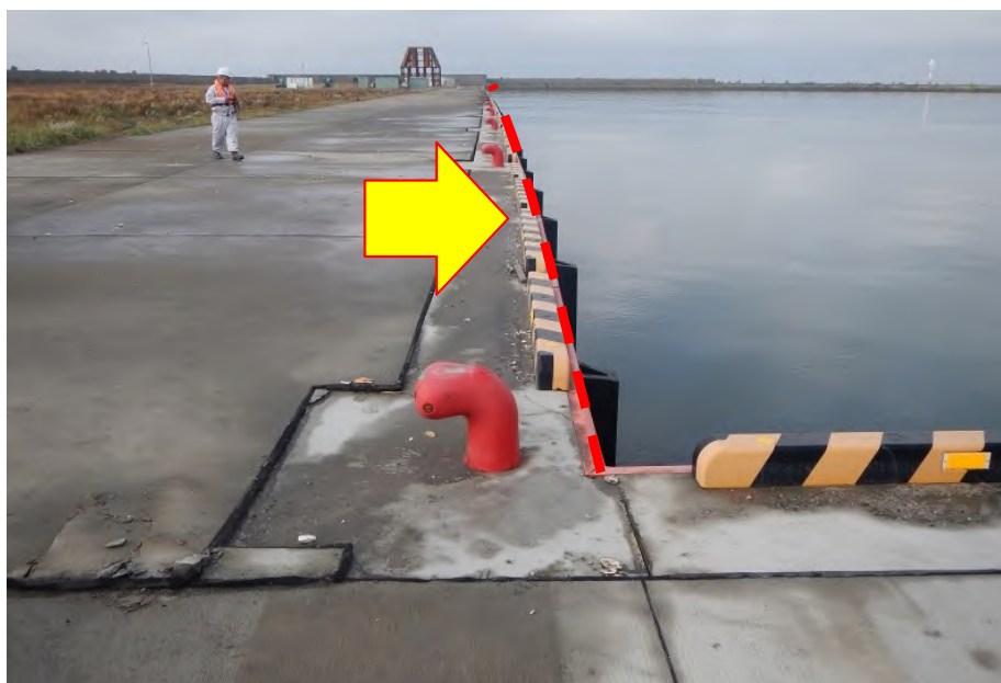
船だまり4m物揚場 本体の迫り出し
