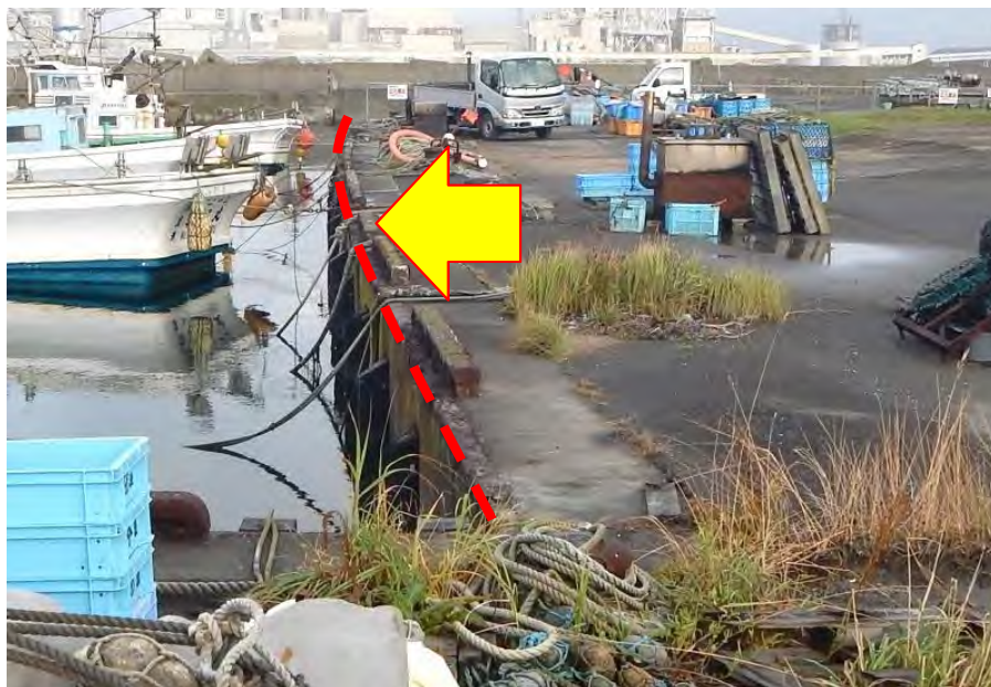
船だまり3m物揚場 本体の迫り出し
