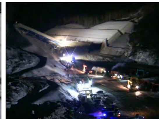
日高幌内 夜間施行状況
