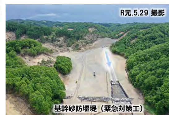
日高幌内川 緊急対策後
