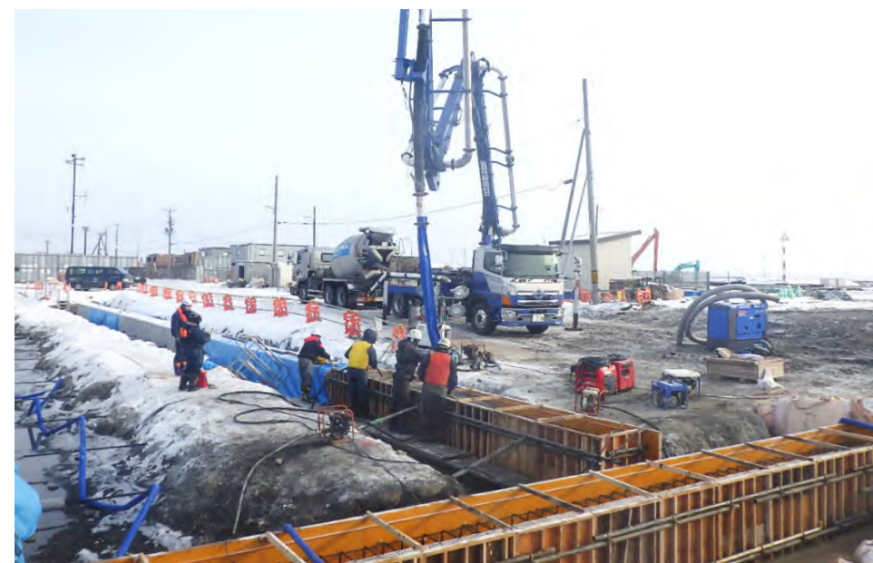
船だまり3m物揚場 控えコンクリート打設状況
