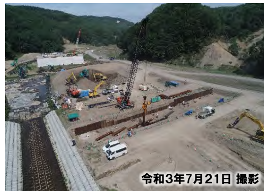
日高幌内川溪流保全工 施工状況 (帯工 鋼矢板打設)
