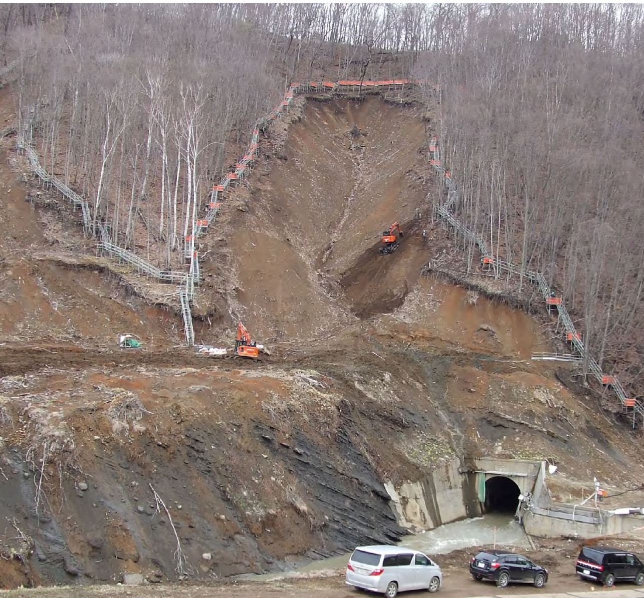
R3.4.14 右岸法面の整備状況
