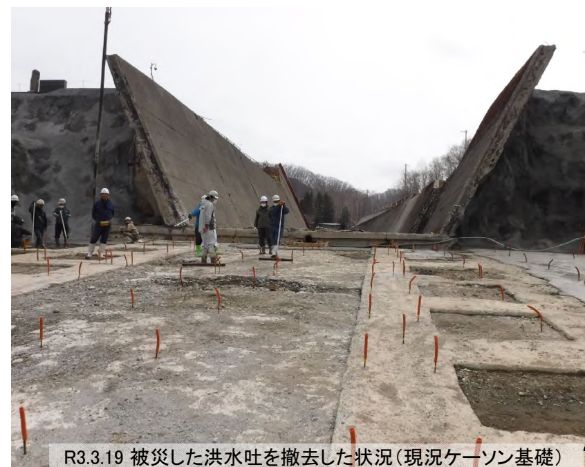
R2.12.24 被災した洪水吐側壁の撤去状況
