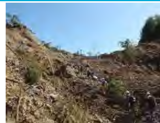
現地調査状況
