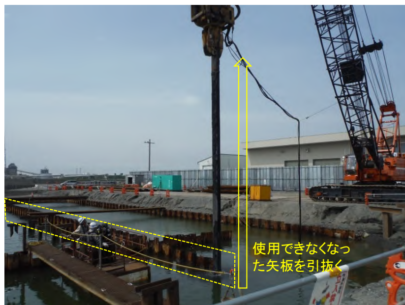
船だまり3m物揚場 矢板引抜き状況
