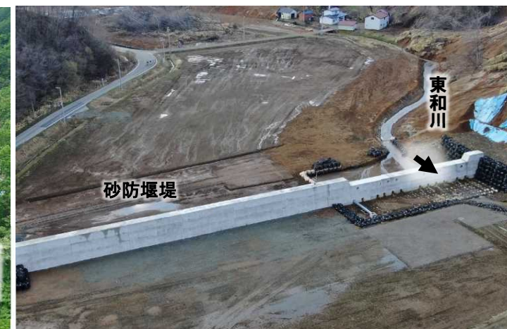
令和2年4月27日撮影(緊急対策完成後)
