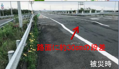
鵠川IC合流部の路面段差
