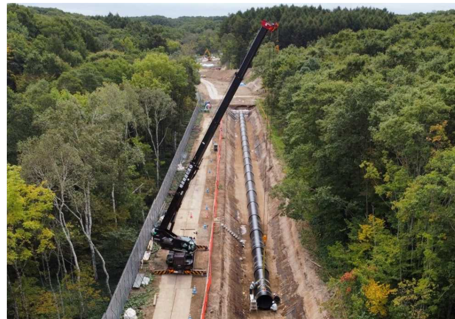
令和3年度工事の施工状況
