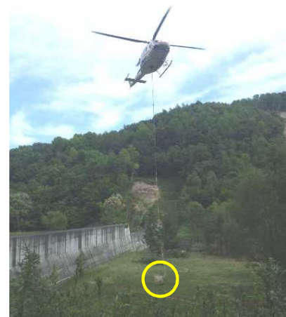
ヘリによる資機材運搬
