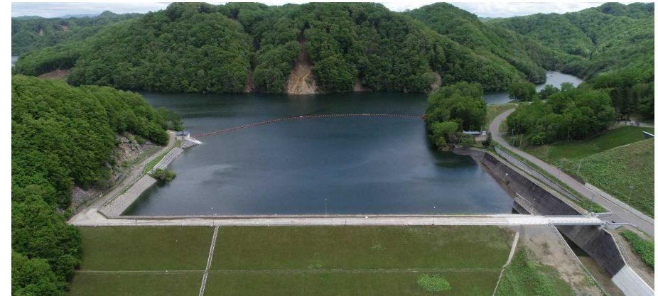
R5.5.30 厚真ダム試験湛水の状況(満水状態)
