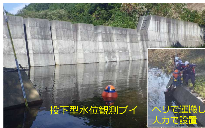
上流側 水位計（投下型水位観測ブイ）
