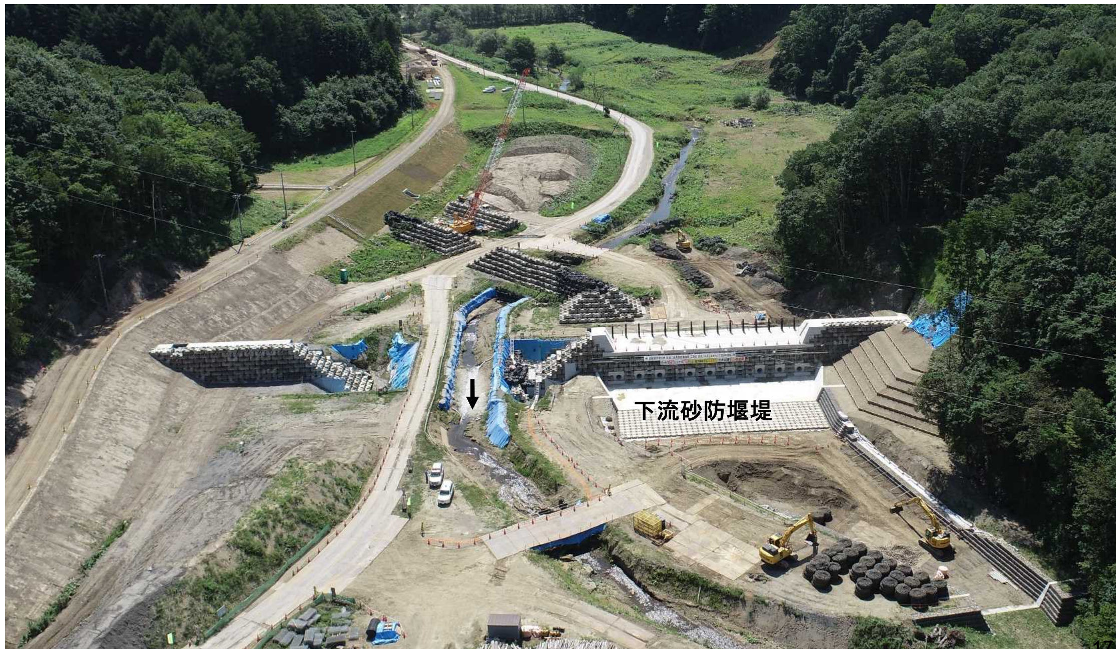
日高幌内川工事状況(R5.8.23撮影)
