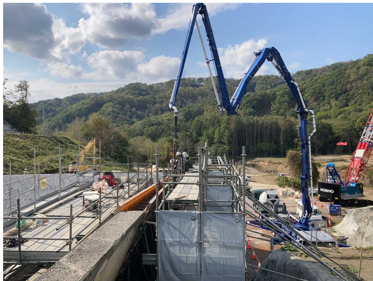
R4.9.29 洪水吐の復旧状況
