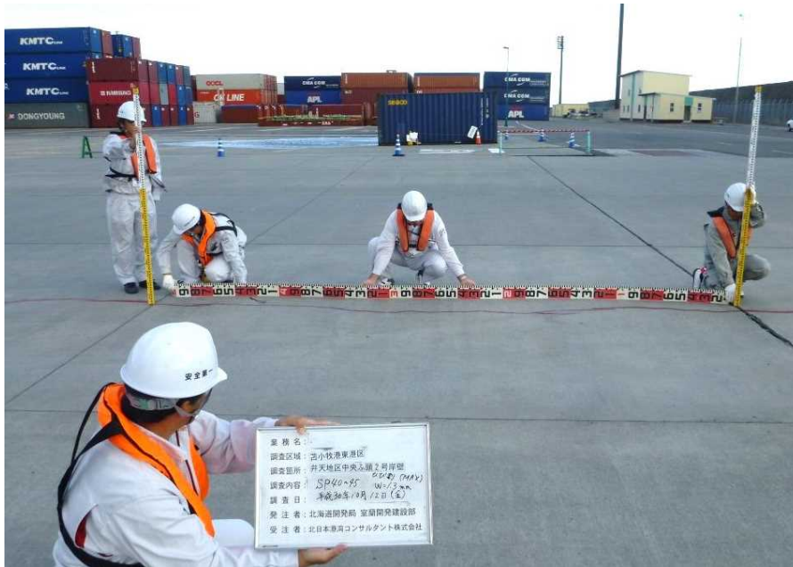
中央ふ頭2号岸壁 エプロンひび割れ
