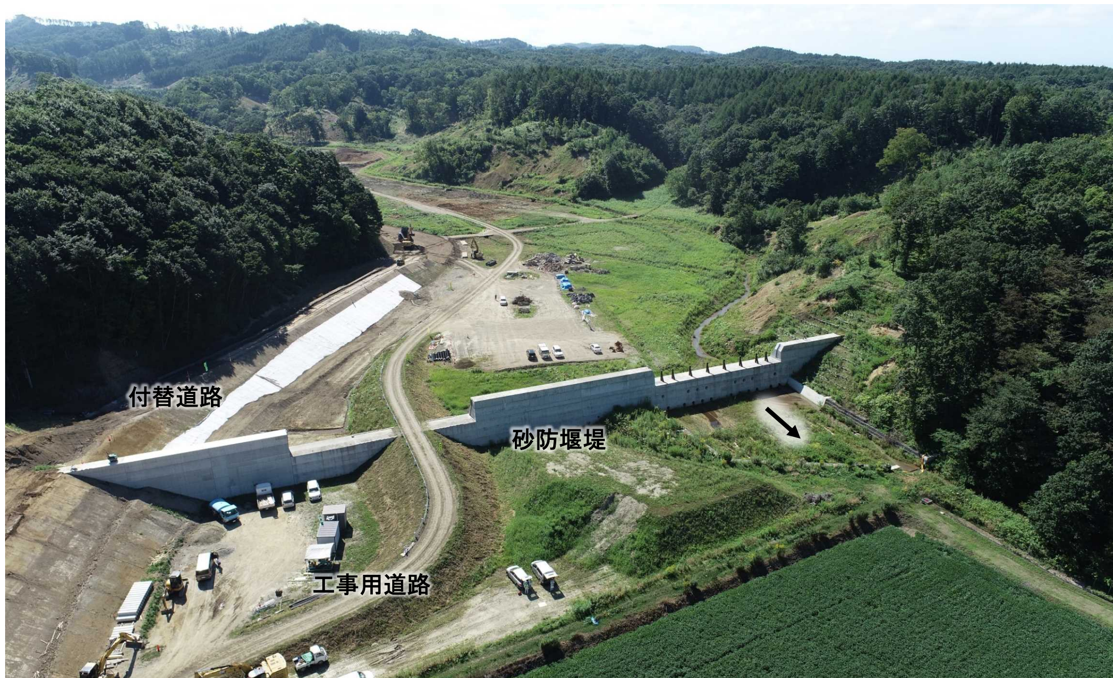
東和川工事状況(R5.8.24撮影)
