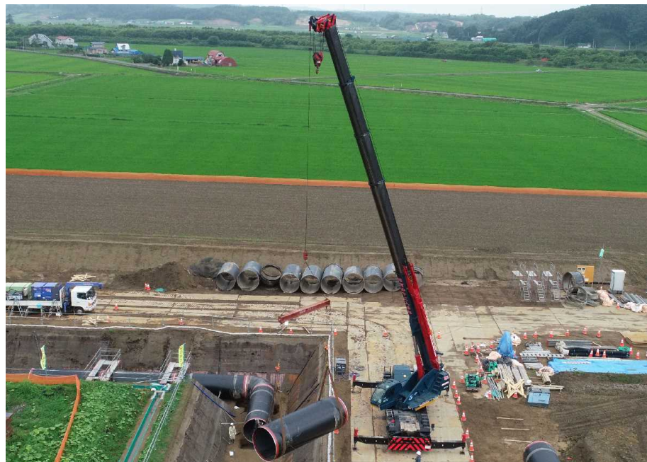
令和2年度工事の施工状況
