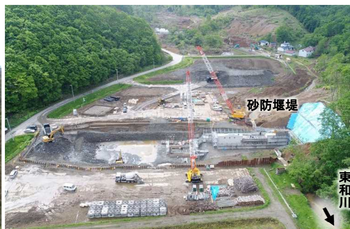
令和元年6月6日撮影(緊急対策施工中)
