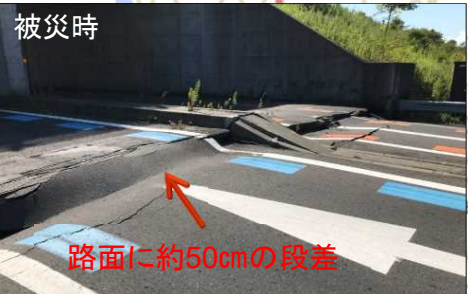
鵠川IC合流部の路面段差
