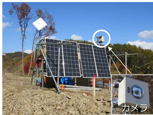
上流側 監視カメラ
