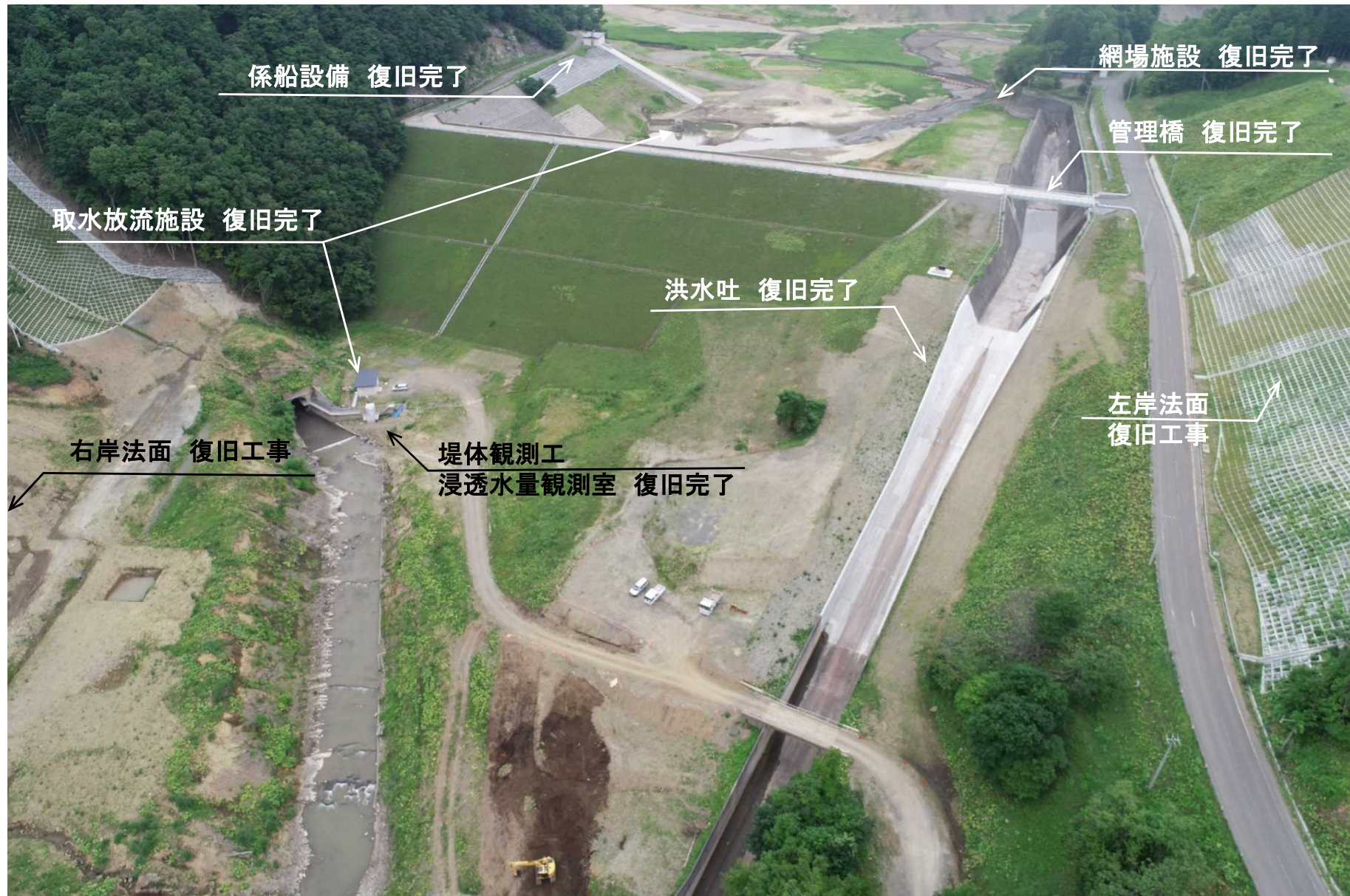
R5.7.24 厚真ダム復旧工事の状況
