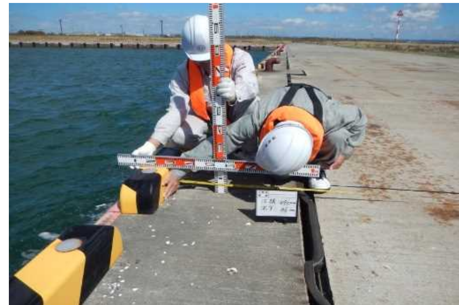
船だまり4m物揚場 上部コンクリート前出し
