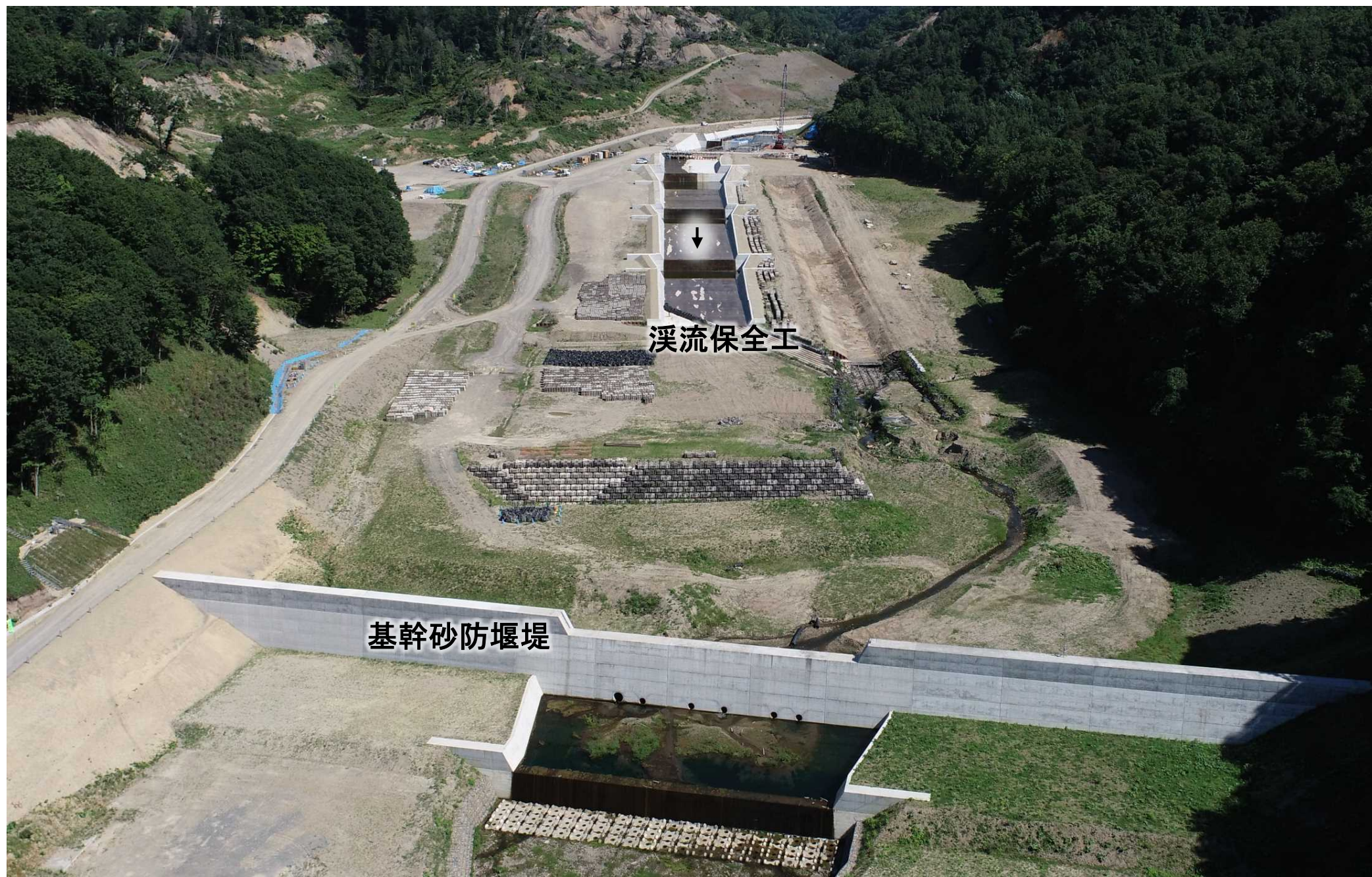
日高幌内川工事状況(R5.8.23撮影)
