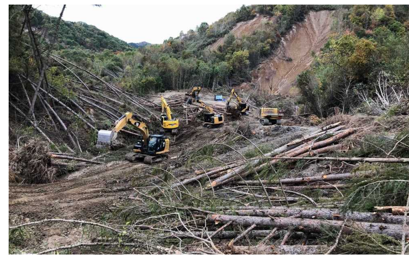
重機による運搬路造成
