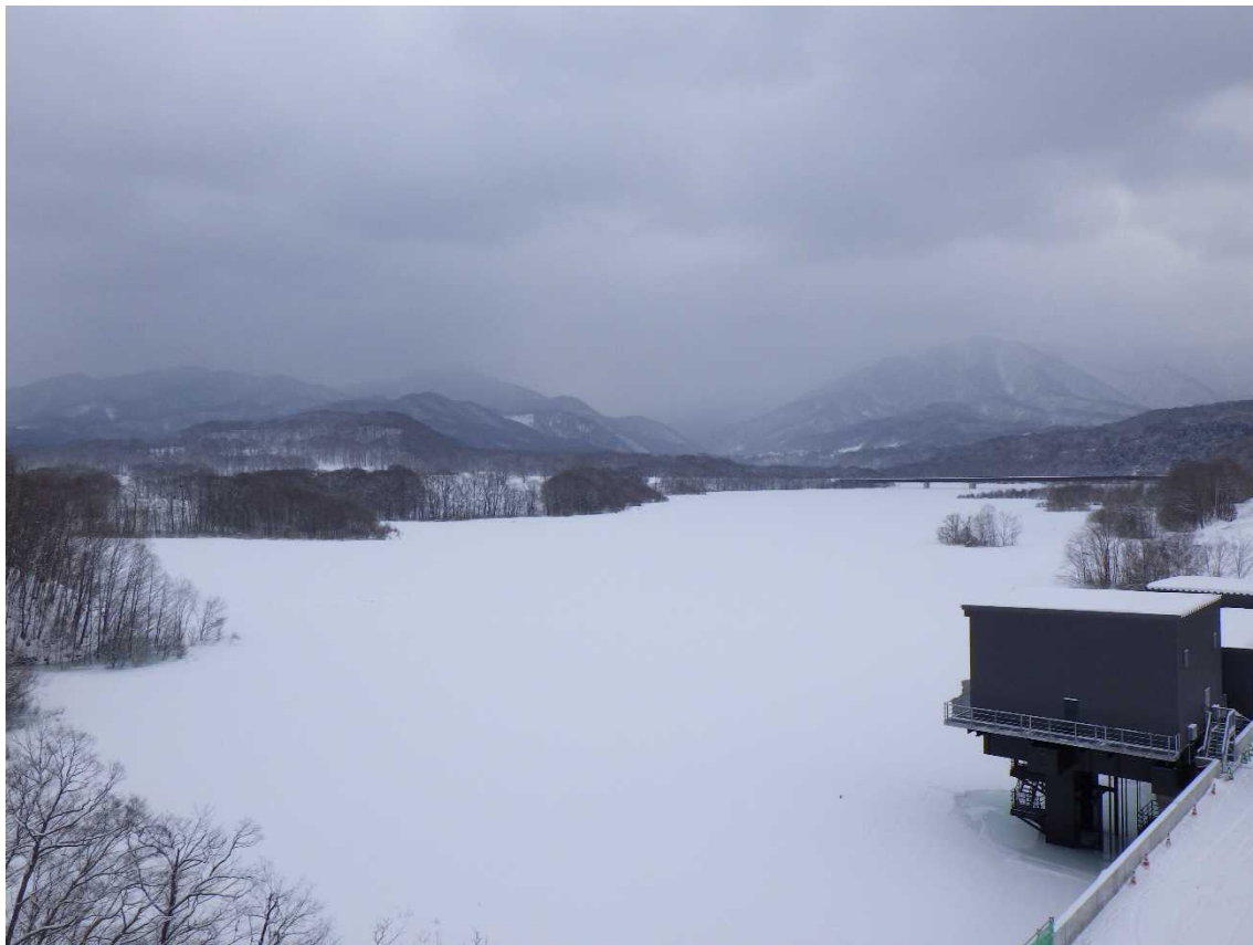
最高水位到達時の貯水状況 令和4年2月13日9時撮影
