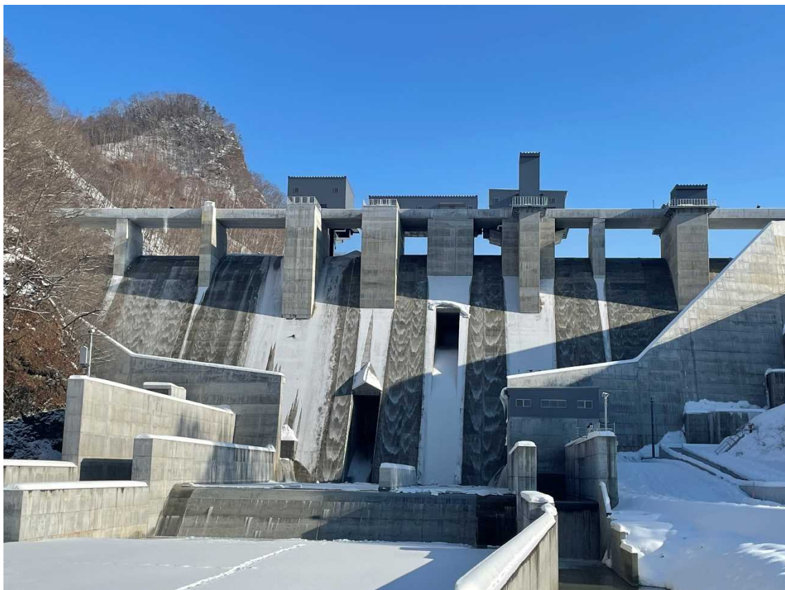
最高水位到達時の放流状況 令和4年2月14日9時撮影
