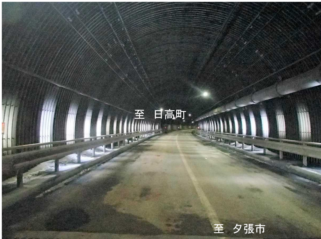
国道274号 モトツシエルターの状況
