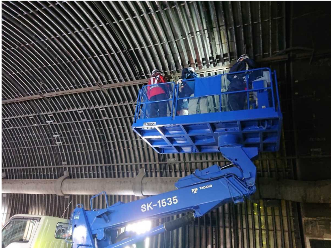
国道274号 モトツシエルターの 調査状況
