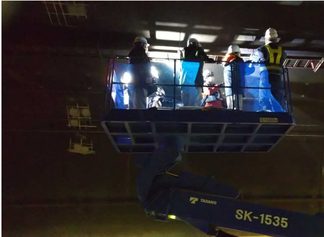
国道274号 モトツトンネルの安全点検状況
