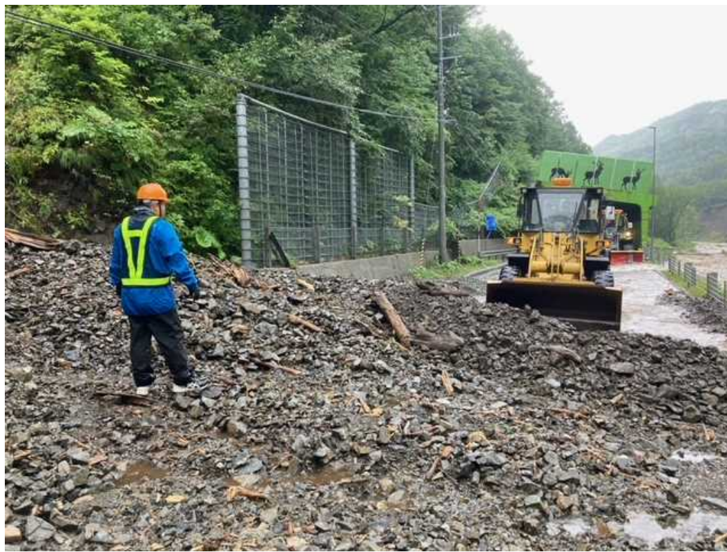
【国道274号 日勝峠 土砂撤去状況】
