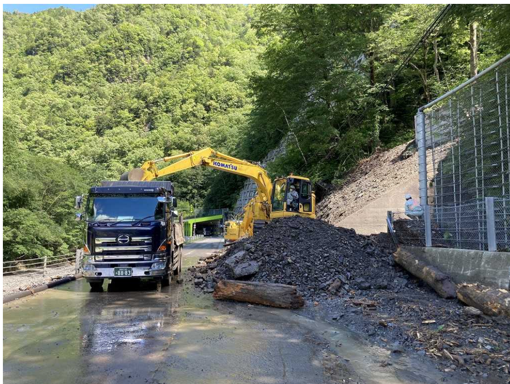
【国道274号 日勝峠 復旧作業状況】 (8月19日 12時頃撮影)
