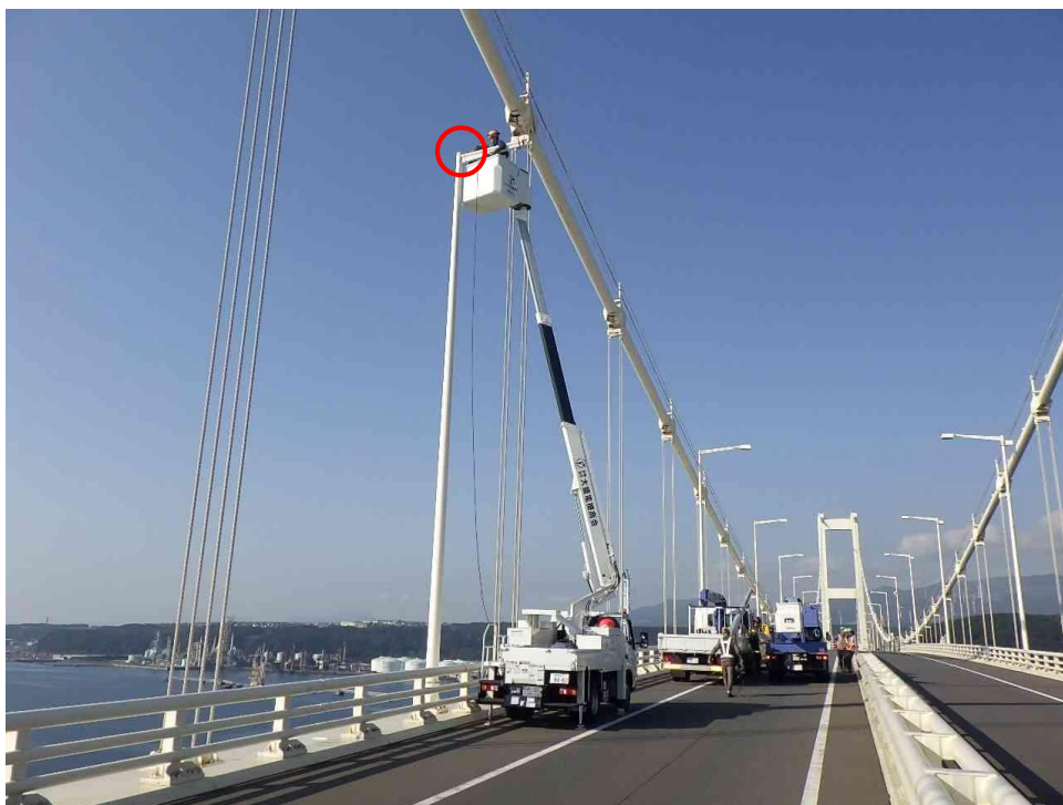
【国道37号 白鳥大橋 道路照明撤去状況】 (9月30日 16時頃撮影)
