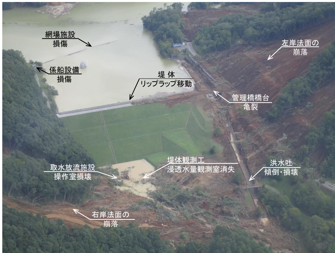
平成30年9月6日撮影 被災直後の状況写真
